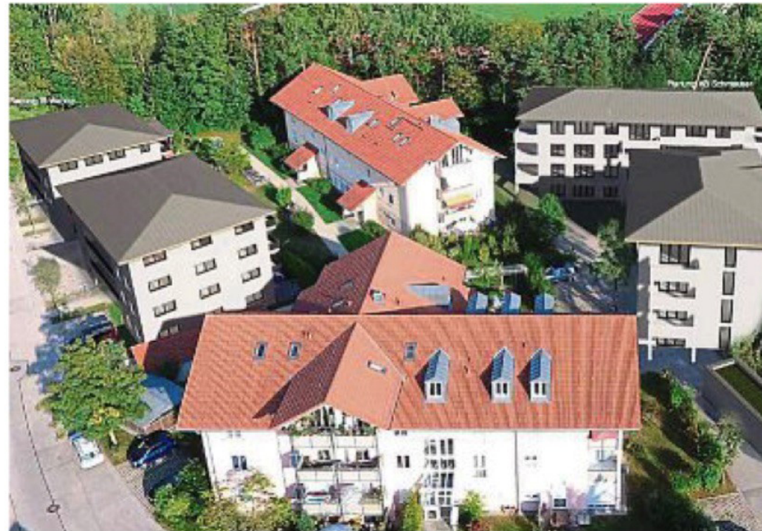
Baugenehmigungen erteilt: So sieht das Grundstück der Baugenossenschaft (BG) Wolfratshausen im Ortsteil Farchet künftig aus. 82 Wohnungen könnte die BG insgesamt dort vermieten.
